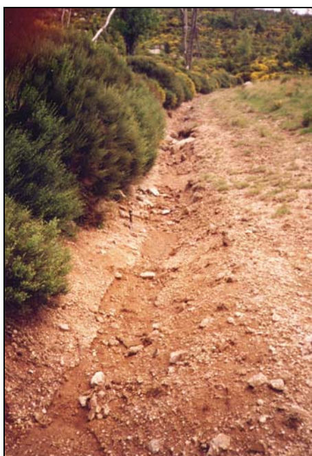
Photo 2 - Traces de ruissellement sur la piste du versant de rive gauche du bassin de la Latte en 2002. [cliché : C. MARTIN]
